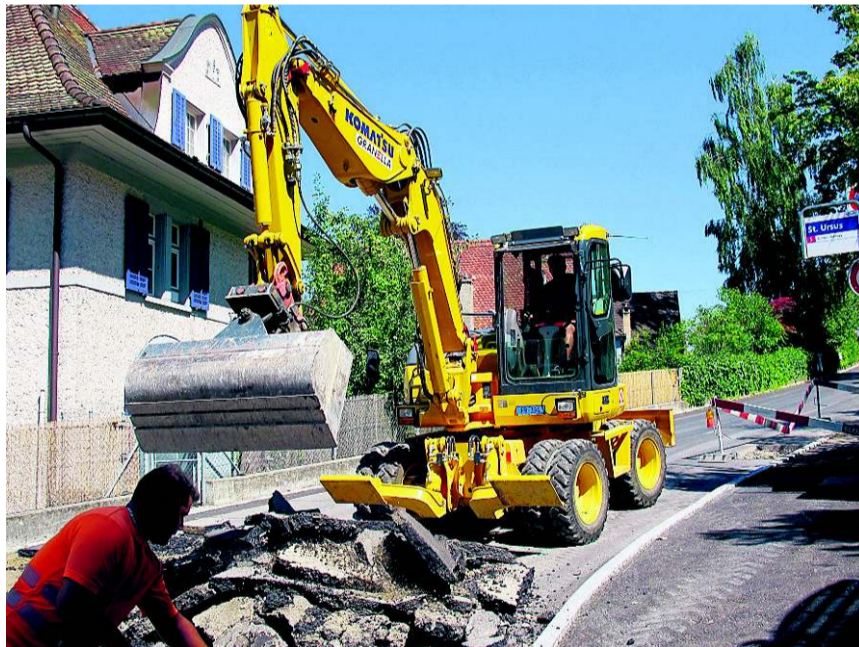
Die Rütistrasse wird aufgerissen und ist nicht befahrbar. RETO BOLLMANN
